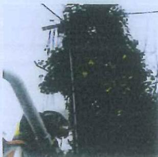
Les plantations situées à proximité des réseaux de communication aériens nécessitent une surveillance et un entretien régulier. Trop proches des câbles, elles peuvent provoquer un mauvais fonctionnement voire une interruption des services de téléphone et d'internet. Le frottement et la chute des branches peuvent ainsi provoquer des coupures aux conséquences graves en cas d'urgence : personnes dépendantes isolées, télétransmissions coupées, alarmes inactives, etc ...
